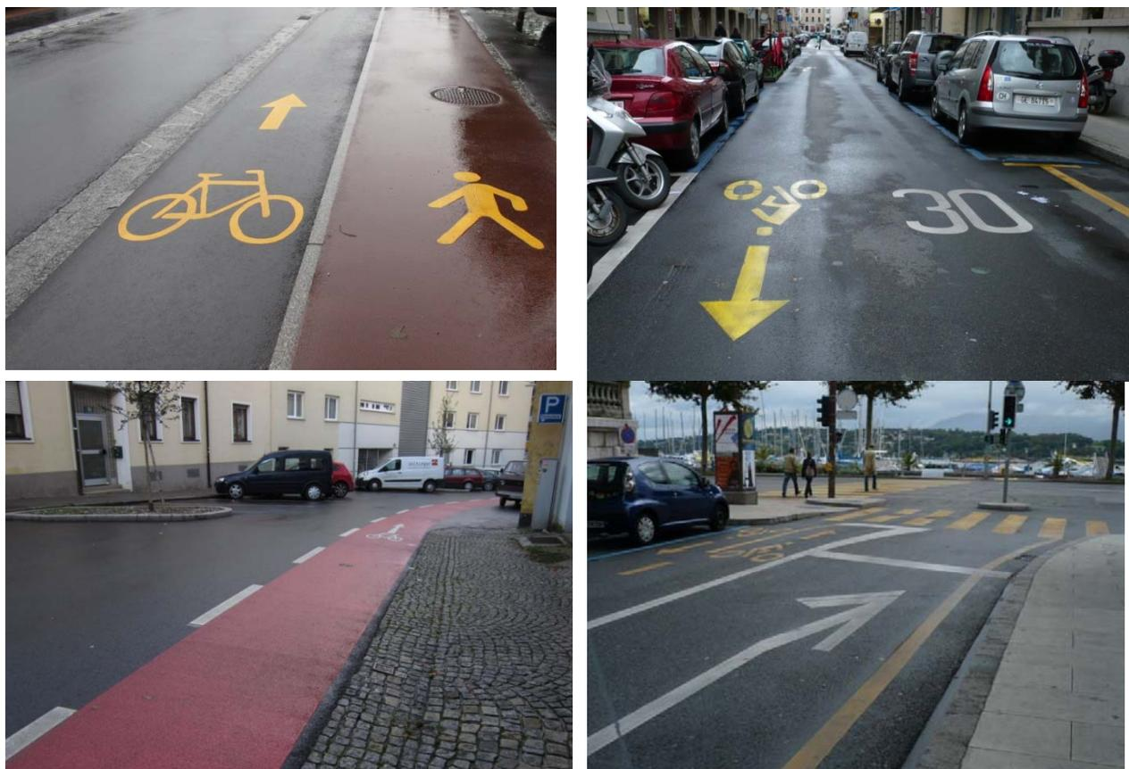
*Esempi di corsia ciclabile in senso opposto a quello del traffico motorizzato e spazio pedonale differenziato ed esempio di corsia ciclabile bisenso in caso di alta frequentazione ciclabile e/o alta densità di traffico*
