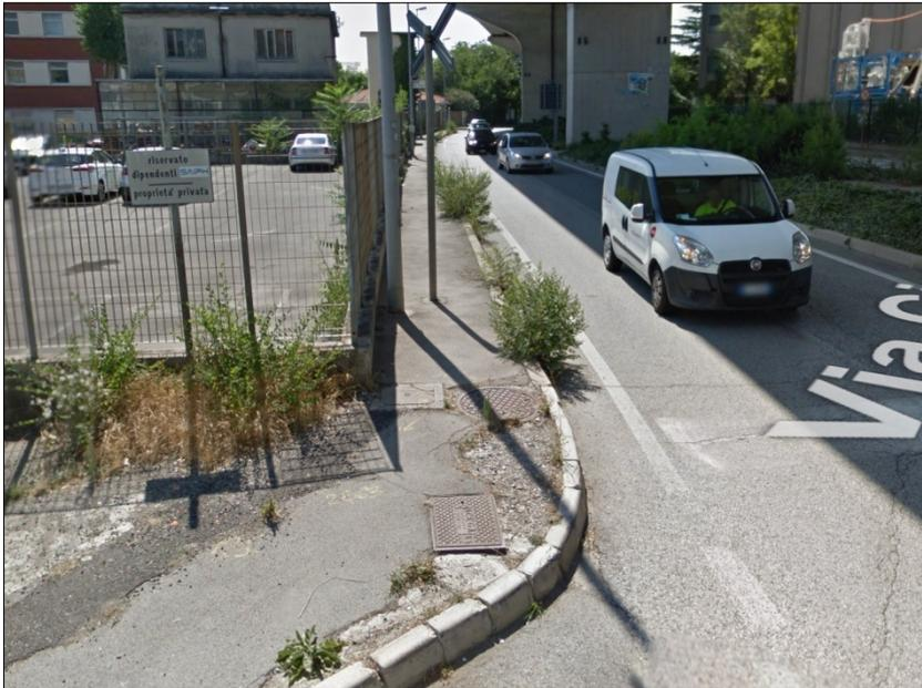
Fig. 2 – Tratto più problematico di via Caboto, in uscita da via Querini: si ipotizza un allargamento dell'esistente marciapiede con esproprio di una fascia dell'area privata (da Google Maps)
