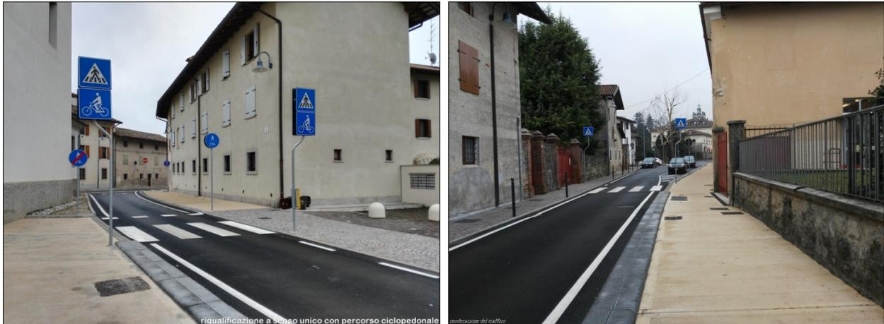
Fig. 6 – Pista bisenso su strada a senso unico (attuando cella di circolazione anche in centri storici minori)
