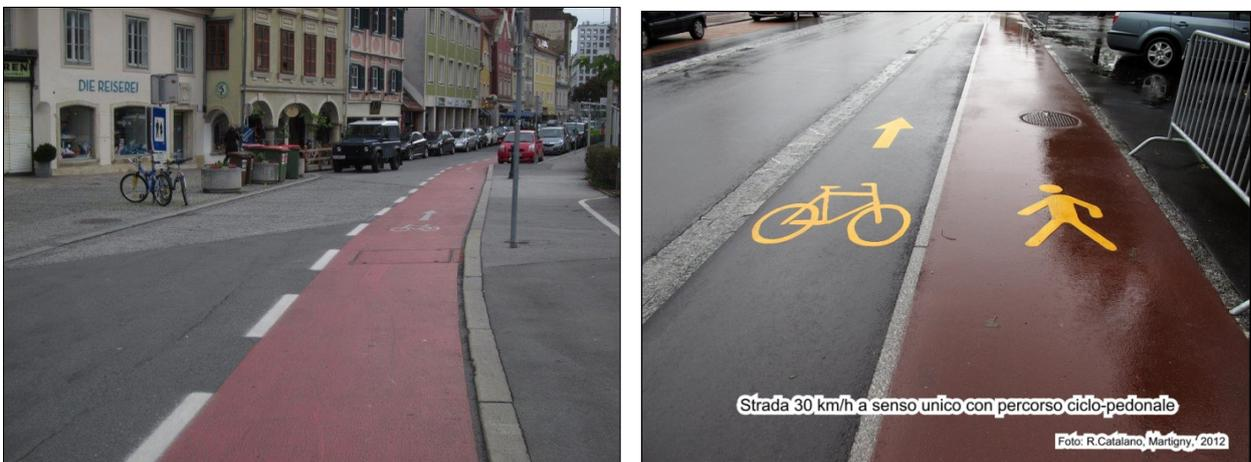
Fig. 5 – Piste monosenso contromano rispetto al traffico motorizzato a senso unico
