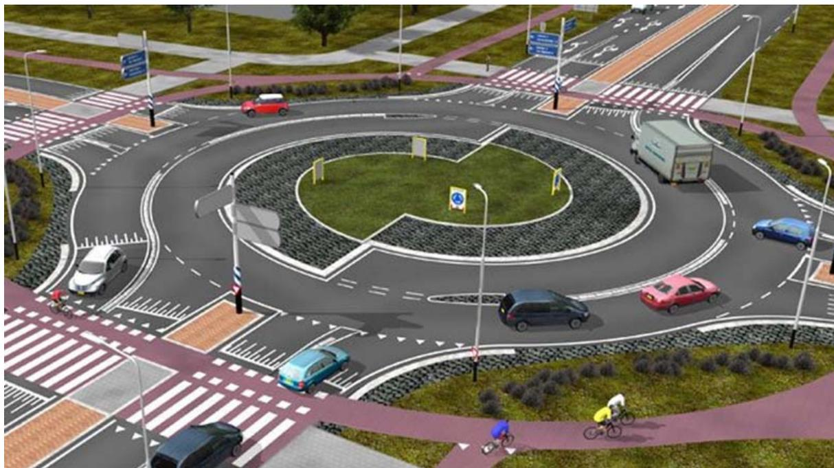
*Esempio di intersezione a turborotatoria*
