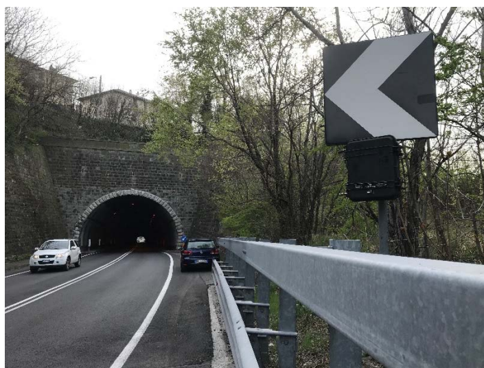
S14A Via Carnaro, in ingresso alla galleria Giovedì 28 marzo 2019
